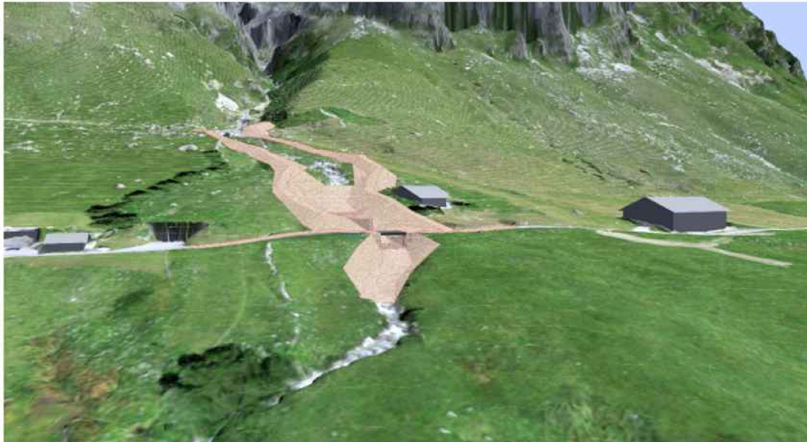
Abbildung 4: Nach Massnahmen in Blickrichtung Nord-Ost.
